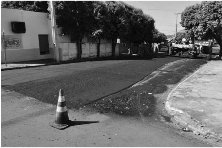
Trecho do recapeamento na Rua 7 de Setembro
